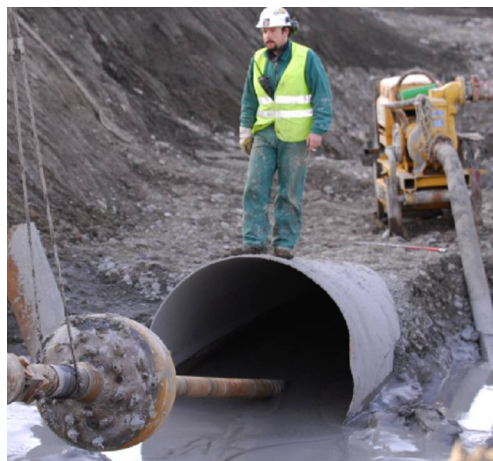
Tubage acier dans les galets et les graviers
