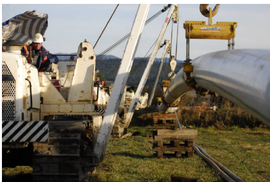
Canalisation de DN600 mm et gaines PE
